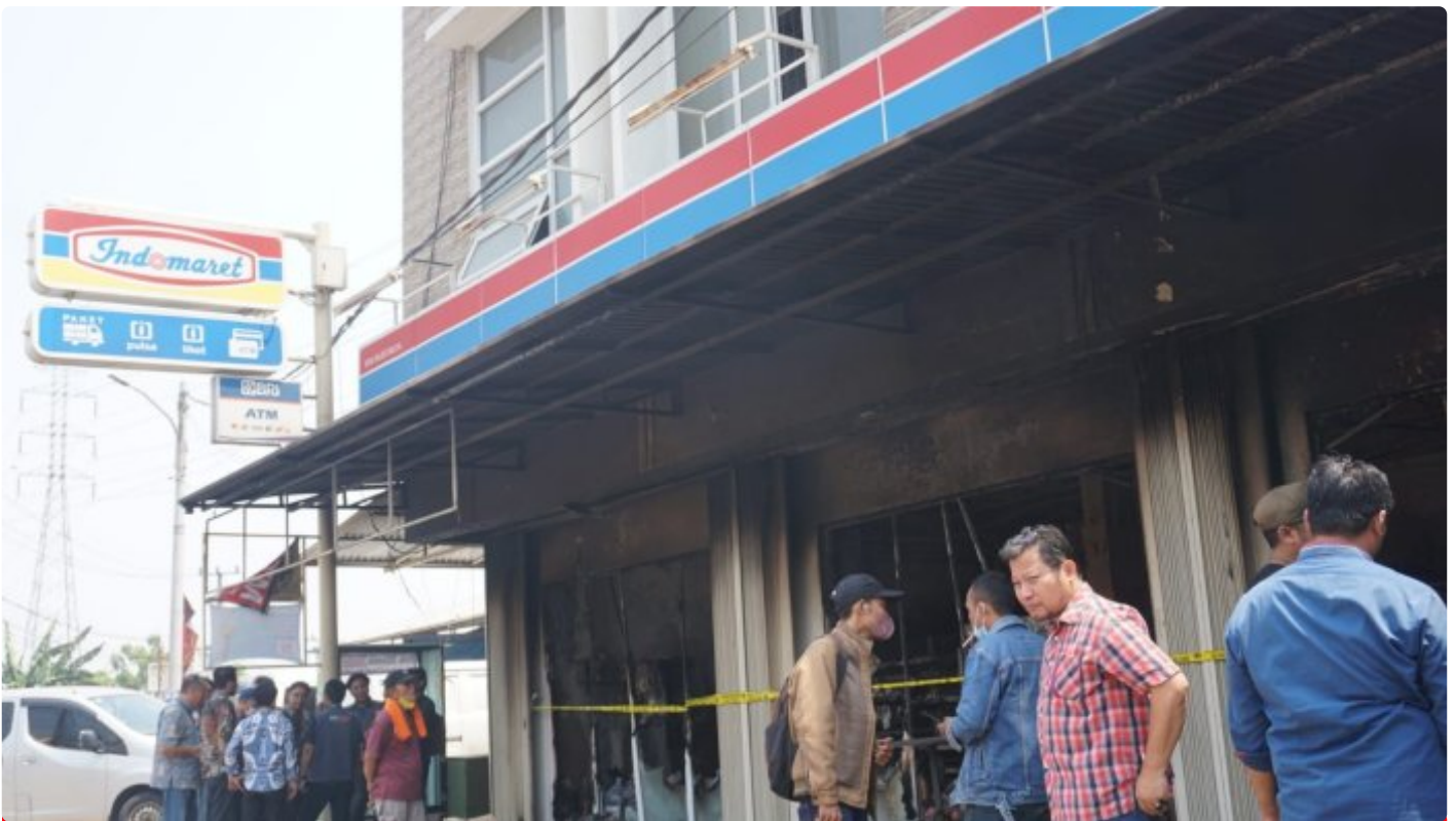
Indomaret Jalan Raya Rajeg Mulya yang kebakaran, Selasa (5/9). Foto: Dokumentasi
